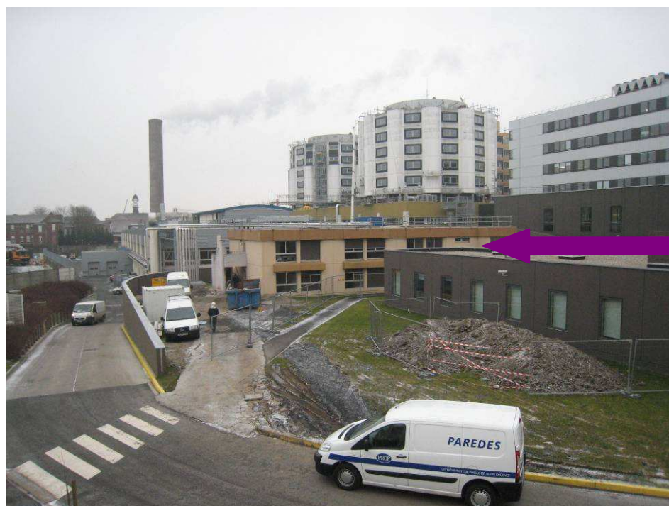
L'Internat pendant les travaux
